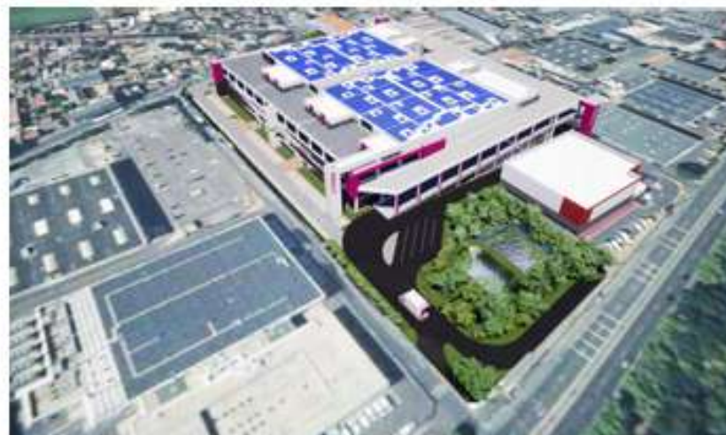
Vue depuis le sud ouest
