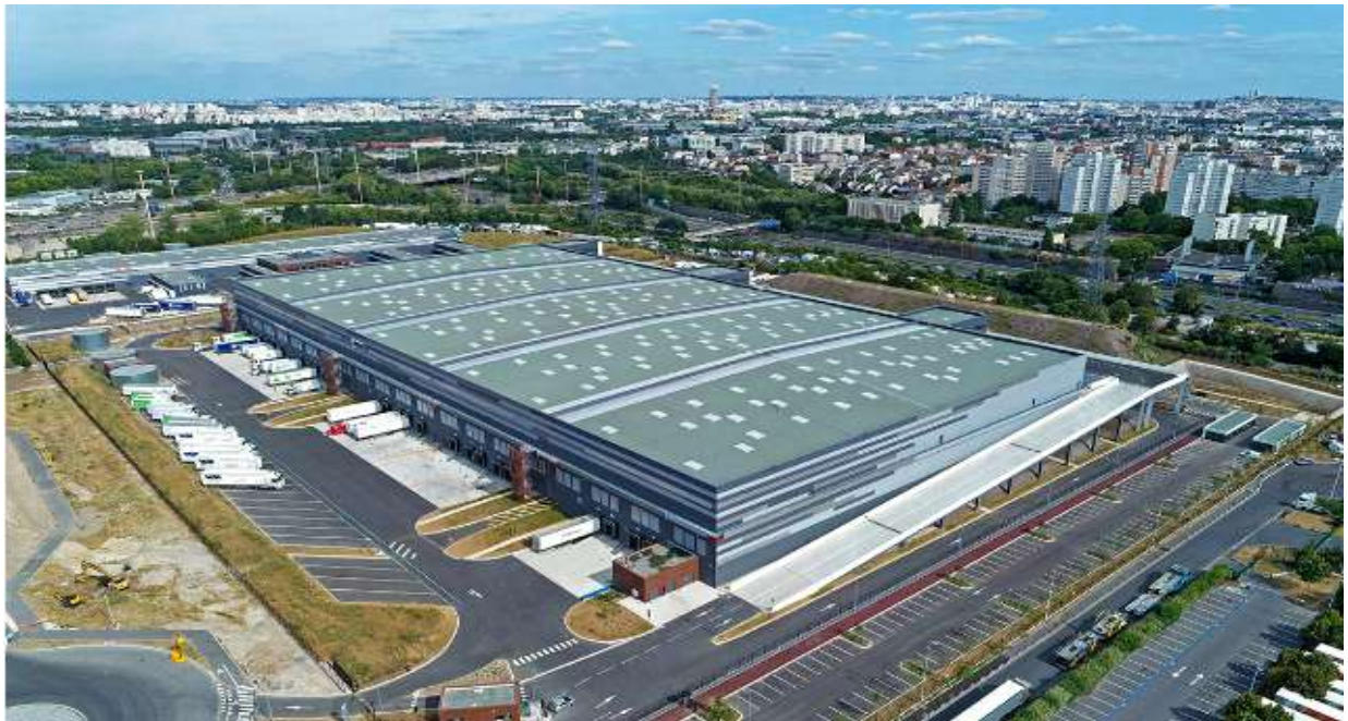
Document 16: Vue du site logistique Paris Air² Logistics à Gennevilliers. La plateforme logistique compte environ 63 000 m² répartis sur deux étages de 31 500 m² chacun. Source: SEGRO Paris
