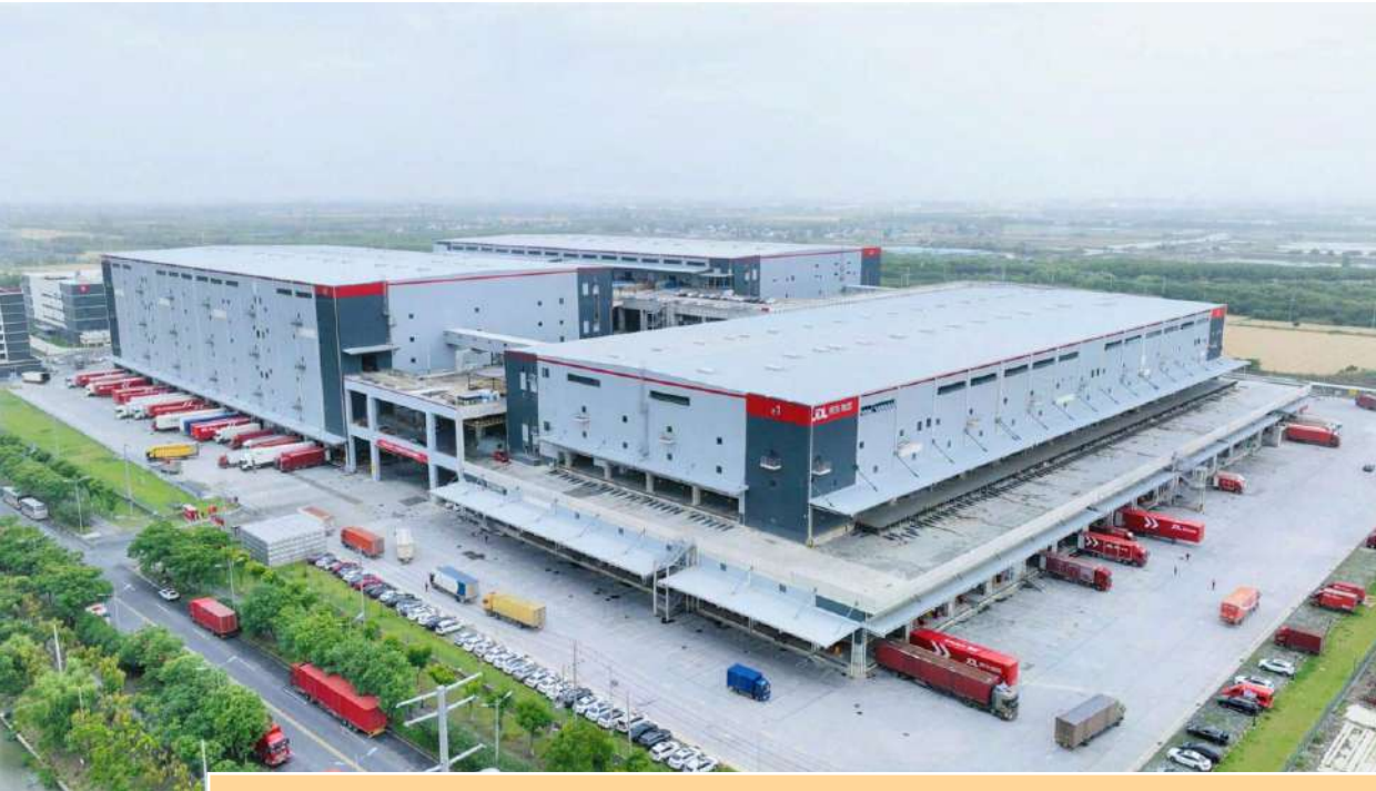
Document 14: Plateforme logistique multi-niveaux de JD.com à Shanghai, entièrement automatisée. Avec ses 100 000 m 2 et une hauteur de près de 28 m, elle traite chaque jour des dizaines de milliers de commandes grâce à la robotisation avancée. Source: JingDong Corporate blog.
