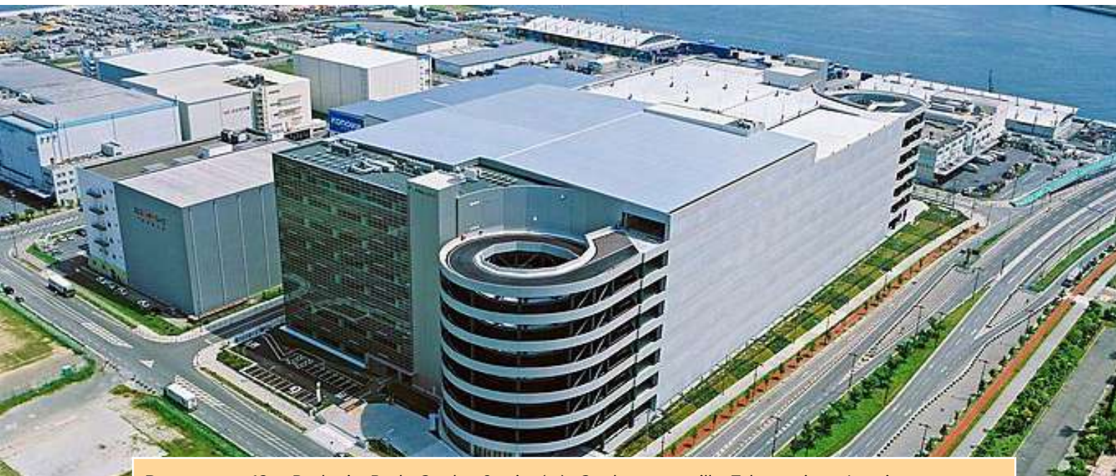
Document 13 : Prologis Park Osaka 2, situé à Osaka, accueille 7 locataires. Le site couvre un terrain de 33 092 m 2 pour une surface totale de plancher de 139 212 m 2 . Source: Nippon Prologis
