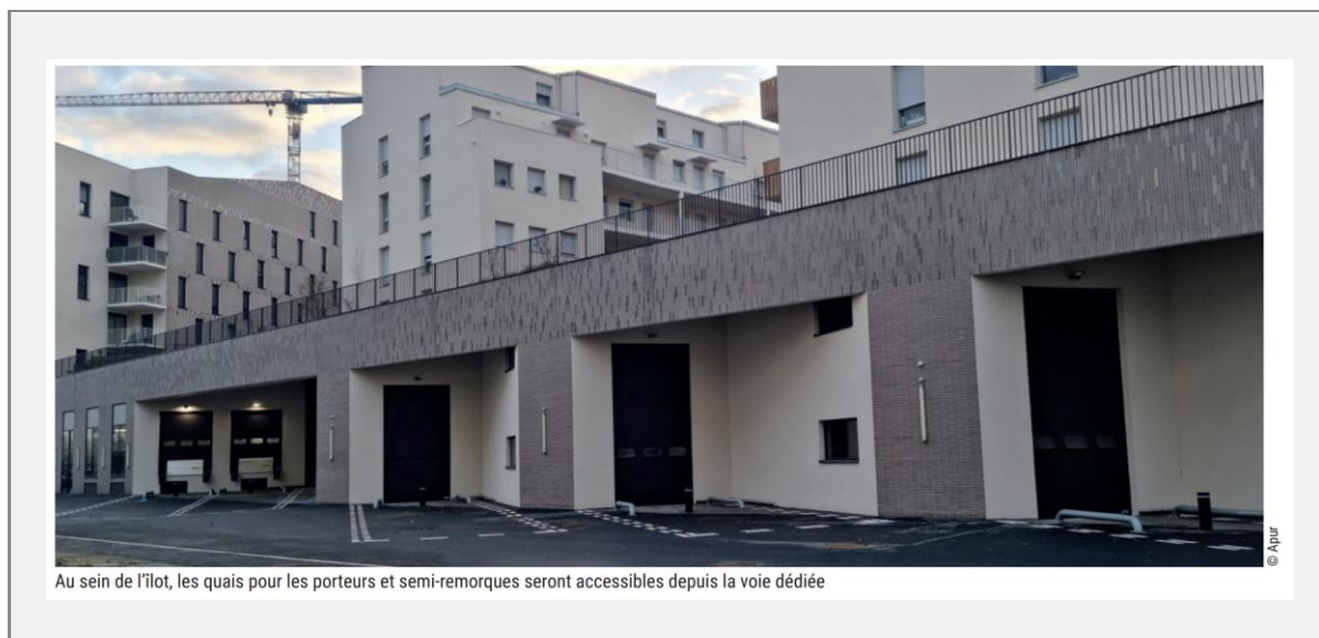
Photographie 22 : Photo de l'ELU Les Lettres (Ivry-sur-Seine, 6 500 m 2 de logistique urbaine en socle de 144 logements sociaux), exemple de mixité logistique-logement programmée dès la conception. Source : Apur (2023) Nouvelles formes d'immobilier logistique - Atlas des projets récents et en cours dans le Grand Paris (page 50)
