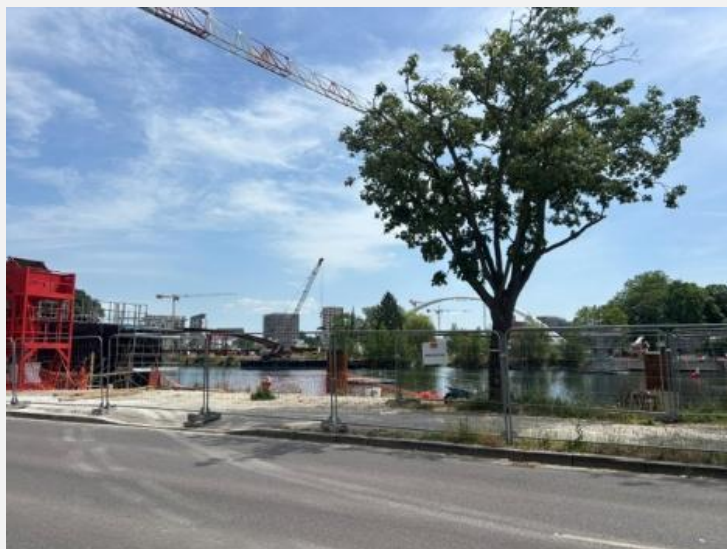
Photographie 17 : Chantier sur les berges du Bassin Vauban au niveau du Parc de la Citadelle à Strasbourg le 30 mai 2026, à 13h11 (L. Coatanéa)
