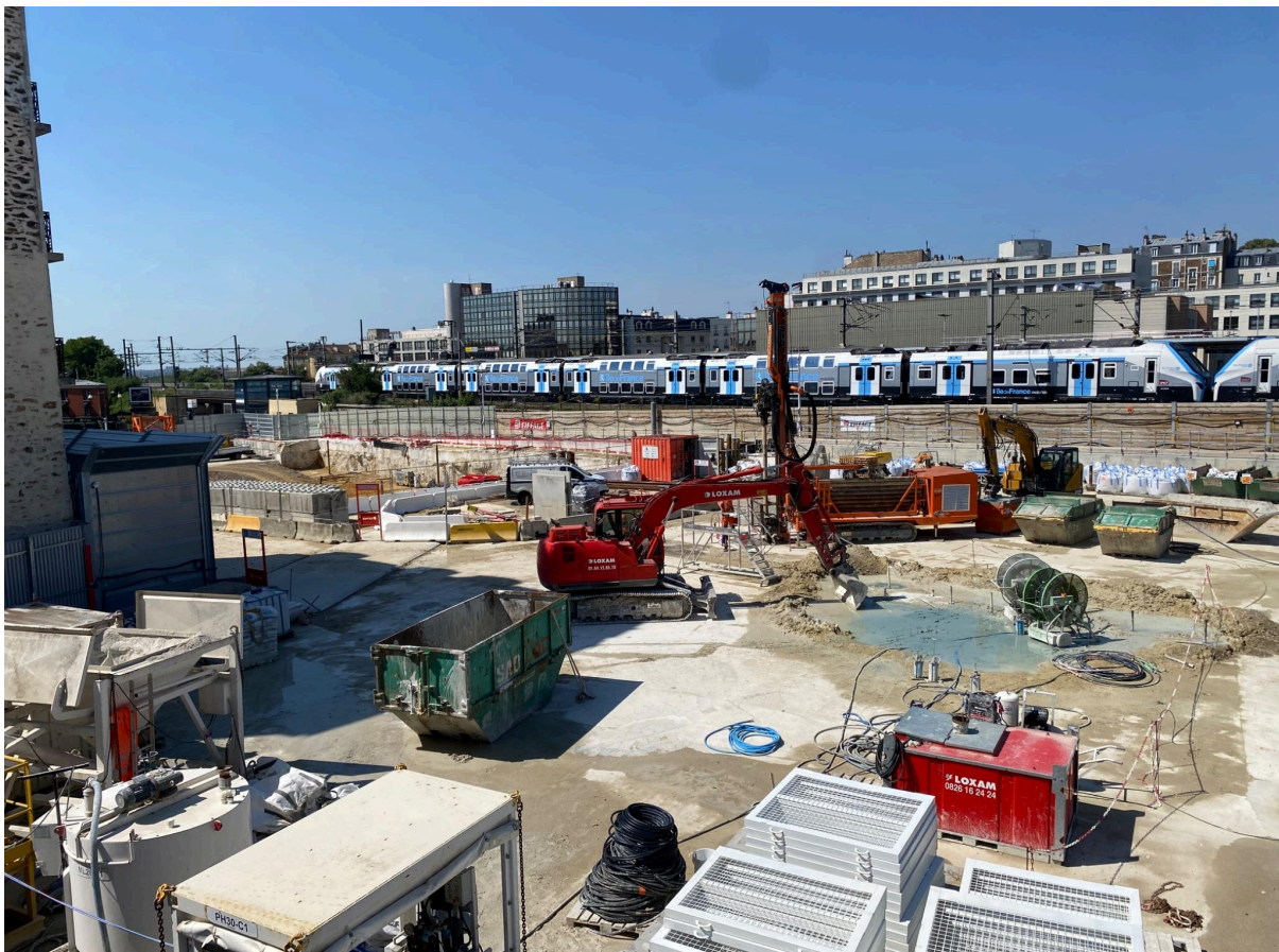
Photo 5 : La gare de Nogent - Le Perreux (94) en chantier - Adèle MAUR, le 19/06/2026 à 11h33
