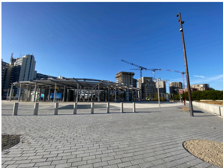
Photo 9 : La gare de Villejuif - Institut Gustave Roussy (94) dans son environnement urbain. On remarque à l'arrière-plan des grues, signe que le quartier est encore en construction - Adèle MAUR, le 08/08/2026 à 19h20
